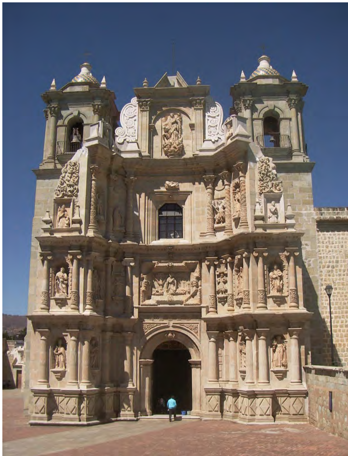
FIG. 19. Vista de la fachada del santuario de la Soledad.
