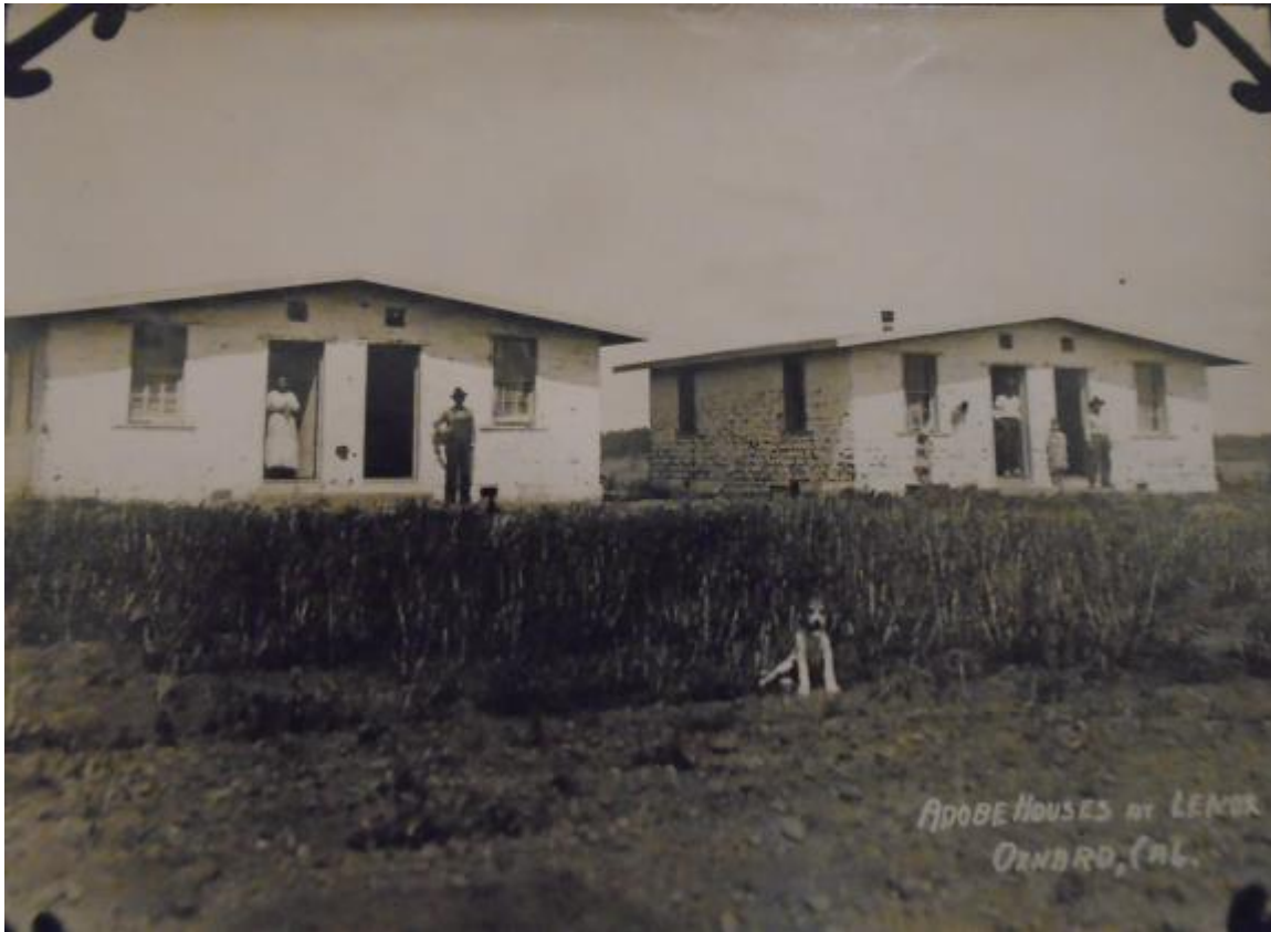
Anexo 3.6. Casas de adobe en el rancho Lenox, en las cercanías de Oxnard, California. ACSCR-MNHS, serie 36: Photographs, clasificación: 145.K.7.14F, caja 160, fólder: Oxnard labor houses, 1917, fotografía s/n.
