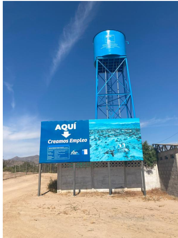
Imagen 7. Torre de agua financiada por el MOP. Punitaqui. Enero 2023.
