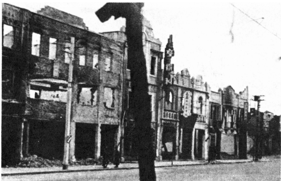
Sección de negocios después de la destrucción de Nanjing.
