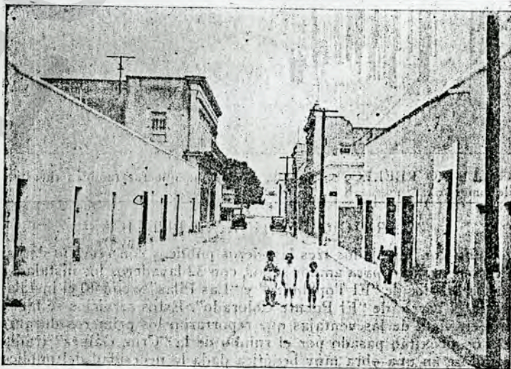
OTRA DE LAS VIAS urbanas modernizadas por el Gobierno, fue la calle de Morelos.
