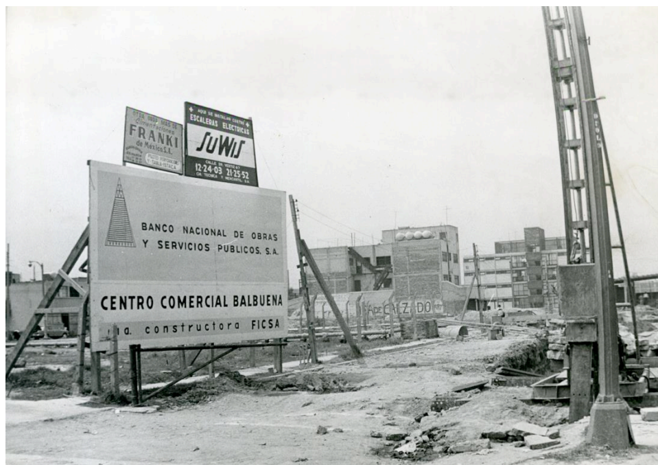
Imagen 5. Construcción del Centro Comercial Balbuena a cargo del BNHUOPSA, por entonces llamado Banco Nacional de Obras y Servicios Públicos. La obra se construyó en Fray Servando Teresa de Mier, 7 de agosto de 1967. Fuente: Archivo Gráfico de El Nacional. Fondo Temático, sobre 126-D. INEHRM.
